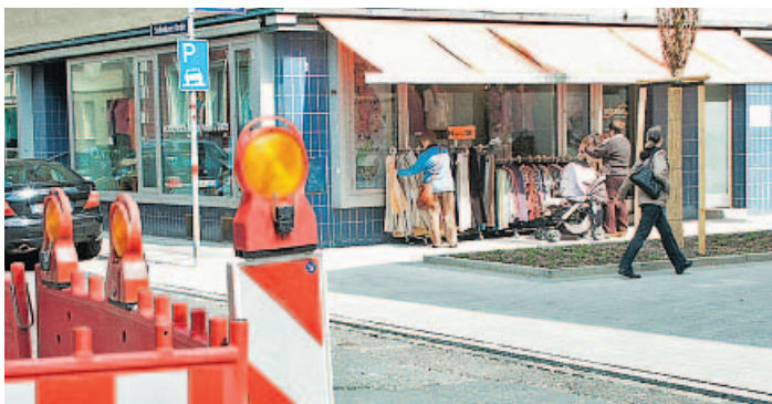
Während nebenan noch gebaut wird, freut sich „Pretty Woman“ über einen freien und gepflegten Zugang.
